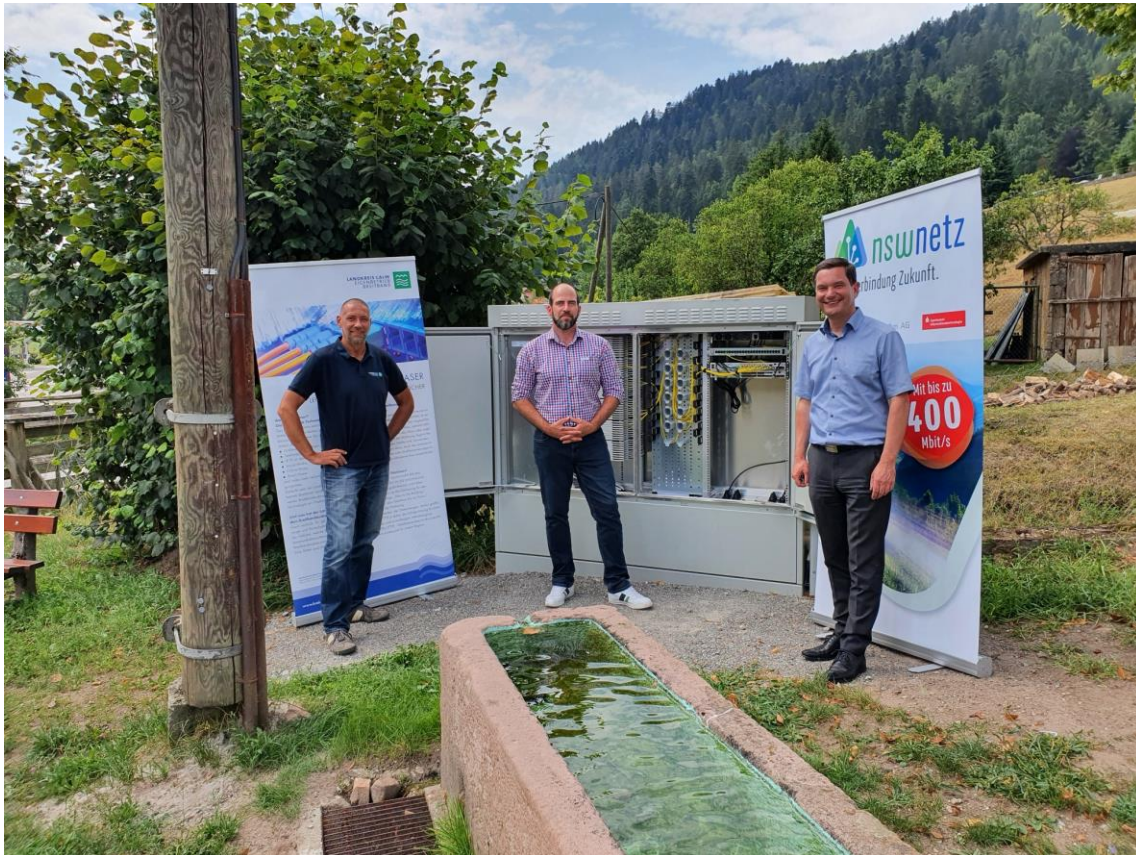
Foto: Bernd Land (Breitband) sowie die Bürgermeister Klaus Mack und Sascha Dengler freuen sich über den fortschreitenden Breitbandausbau
